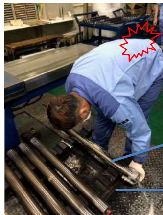
写真2. ロール台車上へのロール移動
