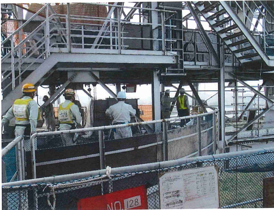
高所作業場所での転落防止状況の安全チェック
