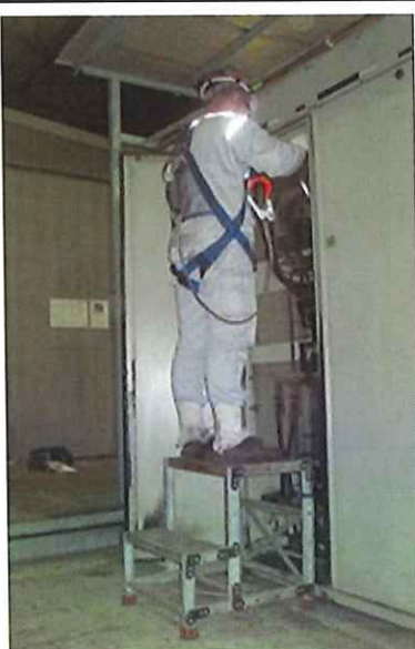
写真1. 結線作業状況
