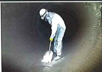
写真1 集塵ダクト内の作業状況 (写真はダスト排出後に撮影)
